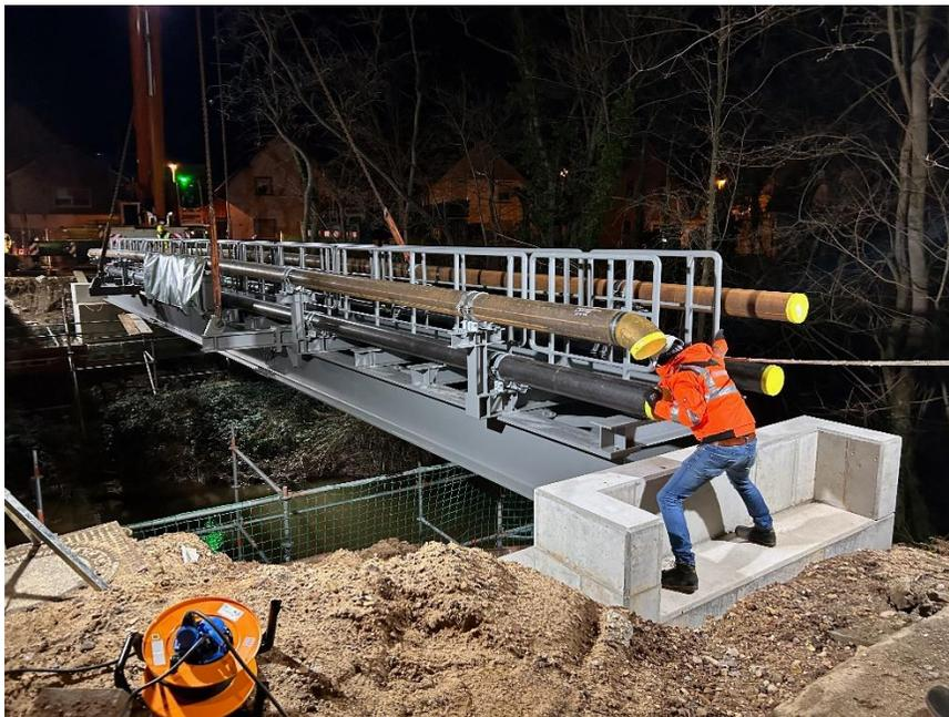
**Fotos (EWR AG):** Die EWR-Leitungsbrücke wird per Schwerlasttransporter in die Wormser Gaustraße gebracht und montiert.
